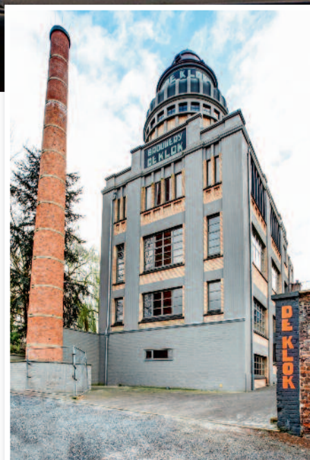
De site van brouwerij De Klok in Zottegem is beschermd erfgoed.
